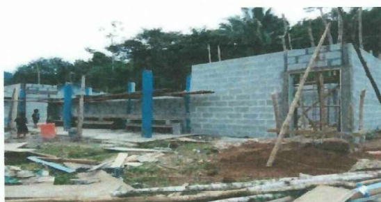
Foto 4: AVANCES DE LOS TRABAJOS DE COLOCACION DE BLOCK
