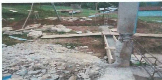
Foto 6: REFORZAMIENTO DE PARALES Y SOLERA
