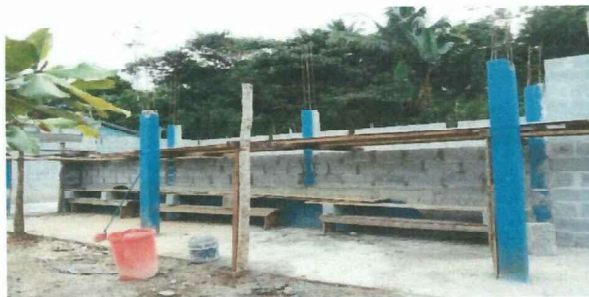
Foto 2: COLOCACION DE ANDAMIOS DE LOS TRABAJADORES
