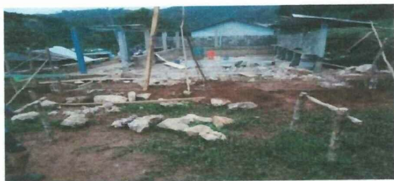
Foto 5: VISTA DE LOS INICIOS DE LOS TRABAJOS
