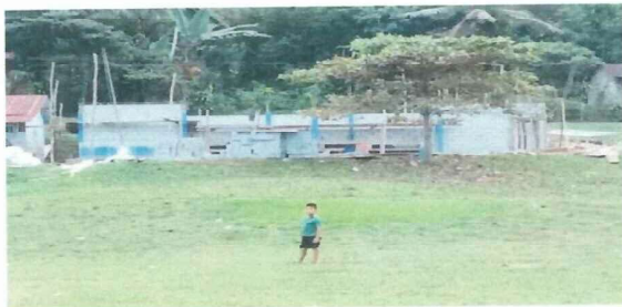
Foto 1: INICIO DE LOS TRABAJOS Y DESMONTAJE DE TECHO
